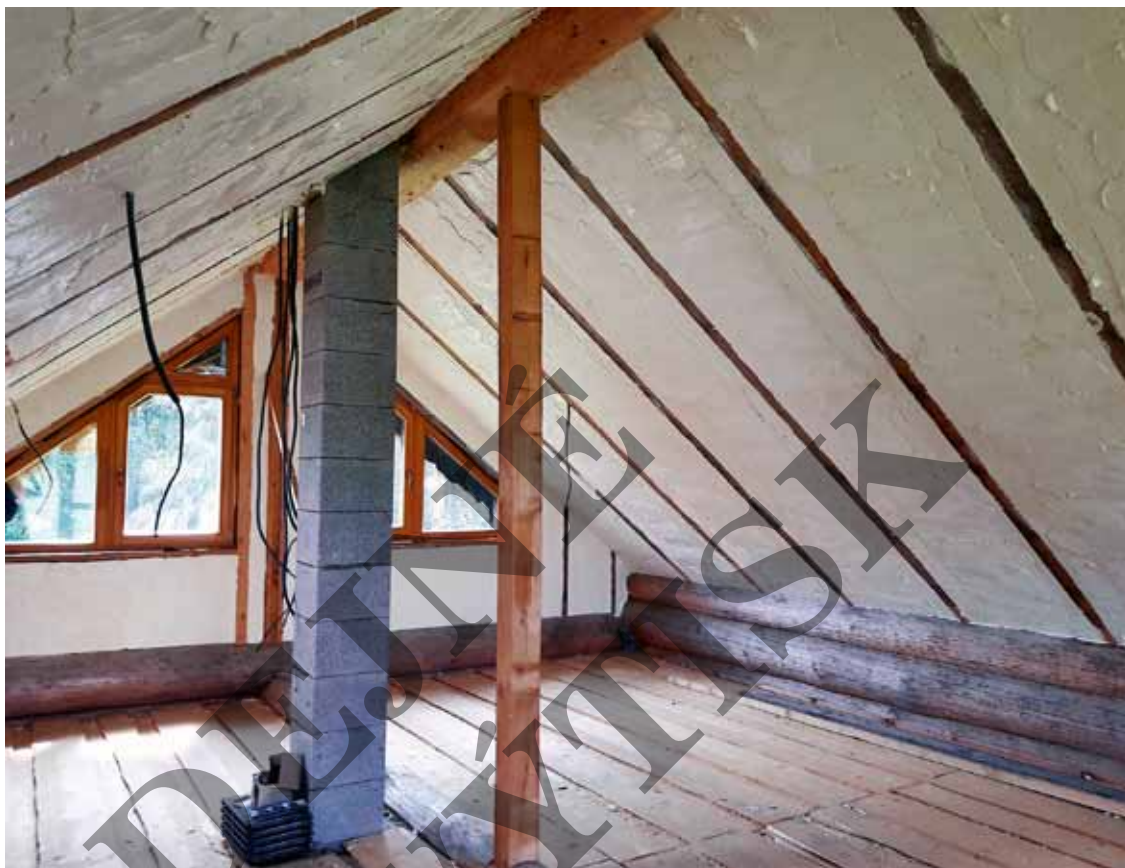
Zateplení půdního prostoru roubenky aplikací izolace Icynene mezi krokve (ICYNENE)
