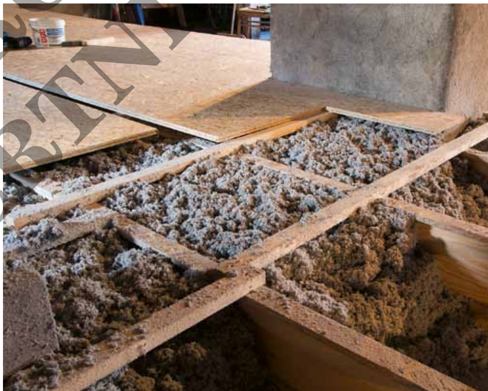
Zateplení stropu foukanou celulózovou izolací Climatizer Plus impregnovanou minerálními přísadami. Ty odpuzují hlodavce, zvyšují odolnost proti houbám a plísním a zlepšují protipožární parametry izolace po aplikaci (CIUR)
