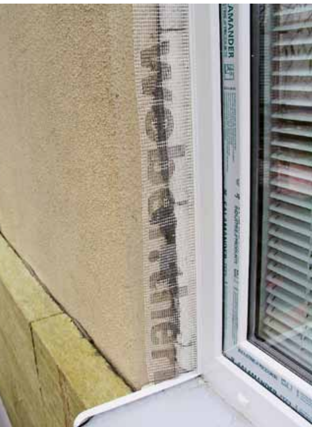
Vnější kontaktní zateplovací systém označovaný zkratkou ETICS je v České republice nejrozšířenější technologií zlepšování tepelnotechnických parametrů obvodových plášťů budov (DIVIZE WEBER)
